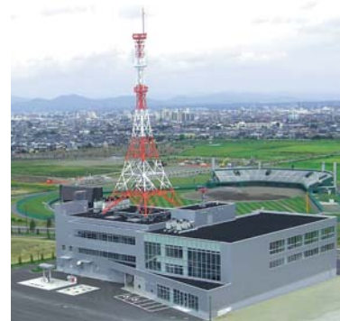
総合防災センター中核施設
